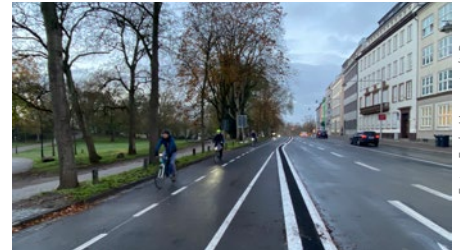
Protektion durch Klebeborde am Wallring, Abschnitt Altenwall
