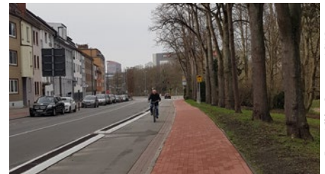
Protektion durch Klebeborde am Wallring, Abschnitt Doventor
